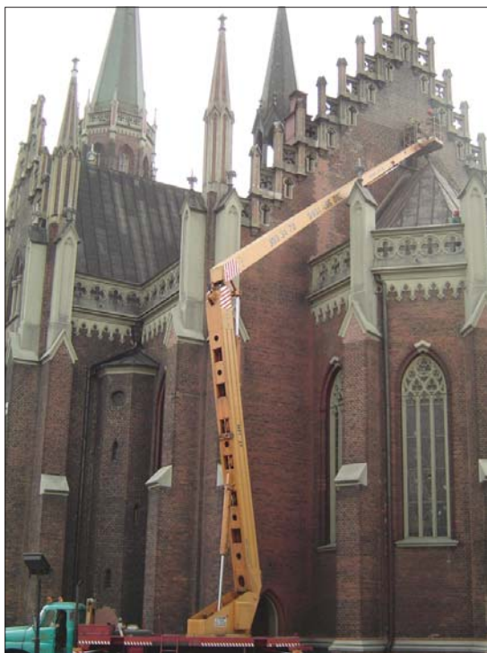
Pemugowcy zabezpieczają przed szkodami górniczymi zabytkowy kościół w Bytomiu-Miechowicach
