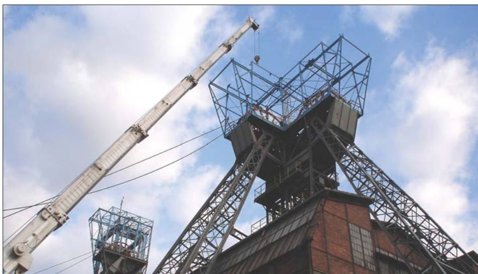
Wymiana koła linowego na KWK „Makoszowy” – czerwiec 2005
