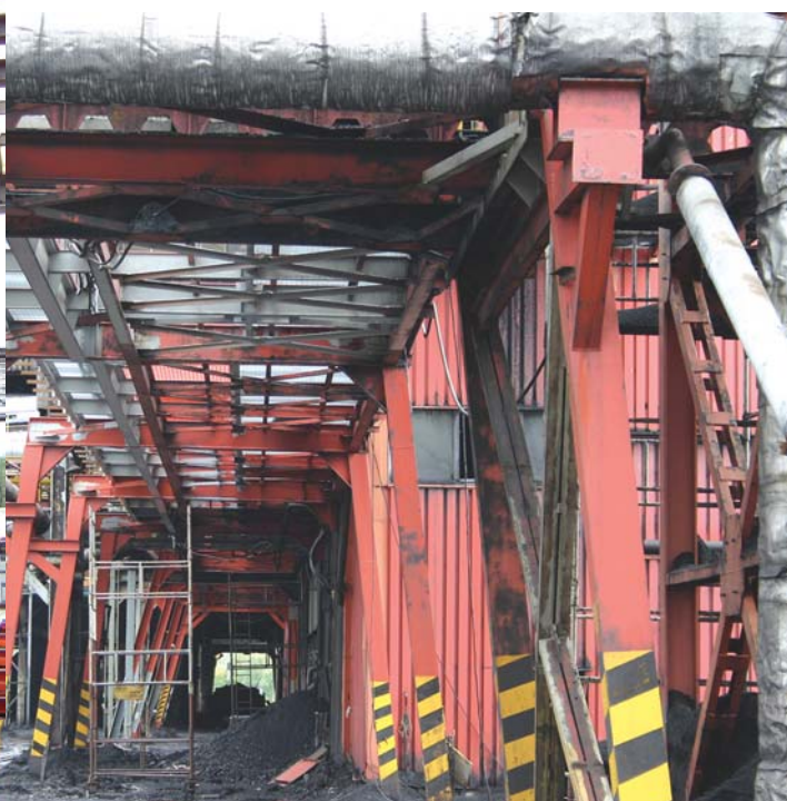
Most M1 w trakcie modernizacji. Szare elementy - wzmocnienia mostów zamontowane przez pracowników „Pemug’u”.
