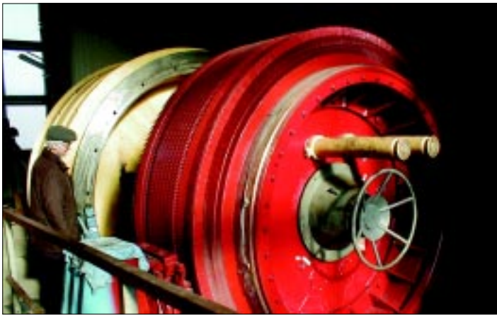
Montaż maszyny wyciągowej na KWK „Jankowice” odbył się na podstawie projektu wykonanego przez czołowego projektanta Biura TMR inż. Krzysztofa Kłyte.
